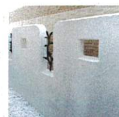
塗り壁の外観デザインに合わせて、塗り壁の壁を作り直しました。アイアンの欄干はお庭主様のお気に入り♪
